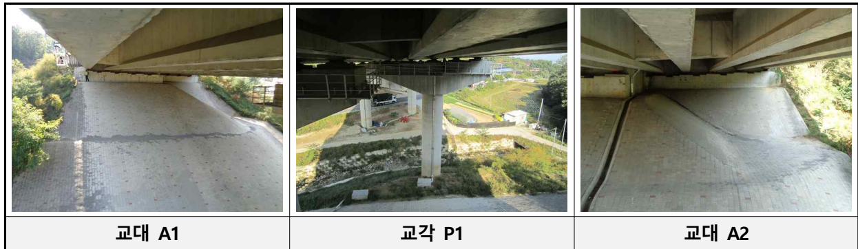
[교대 및 교각 전경]
