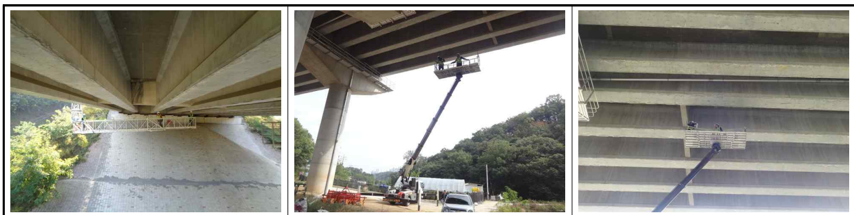
[고소작업차, 굴절점검차를 이용한 근접조사 실시]
