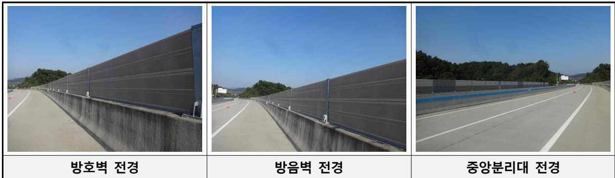
[방호벽 및 방음벽 전경]
